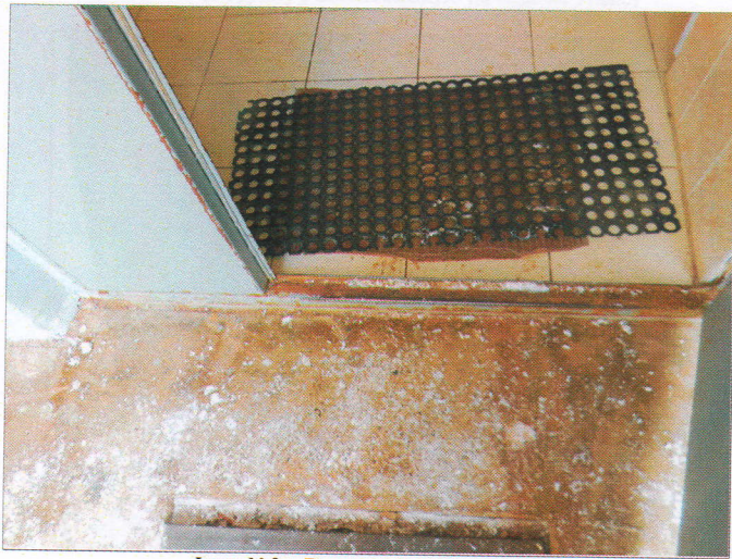
Фото №9 – Внешняя входная дверь
