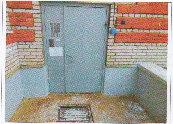
Фото №8 – Входная площадка главного входа
