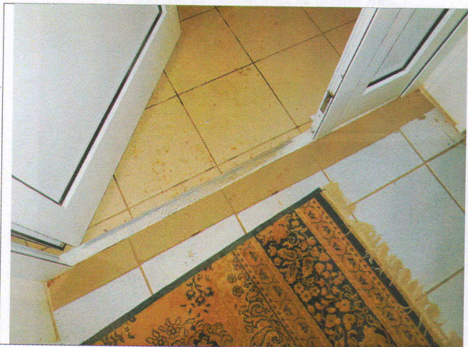
Фото №11 – Внутренняя входная дверь.
