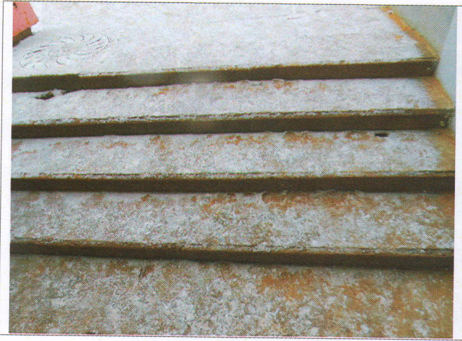
Фото №7 – Наружная лестница
